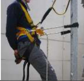
Cuando el electricista realiza trabajos en altura debe usar un arnés de seguridad de cuerpo entero y otros elementos para, que en caso de accidente, se pueda detener la caída.
